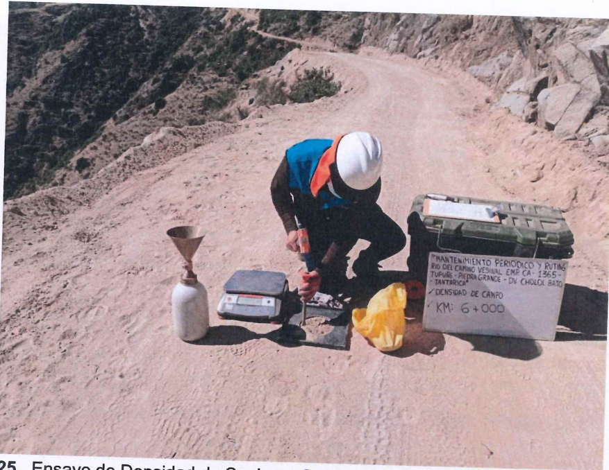
FIGURA N° 25. Ensayo de Densidad de Suelo en Campo. Progresiva 06 + 000 (Método del cono de arena).
