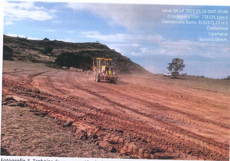
Fotografía 3. Trabajos de recuperación de áreas ocupadas.
