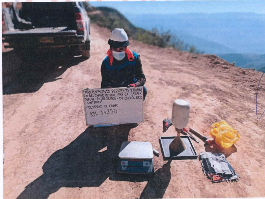
FIGURA N° 6. Ensayo de Densidad de Suelo en Campo. Progresiva 01 + 250 (Método del cono de arena).
