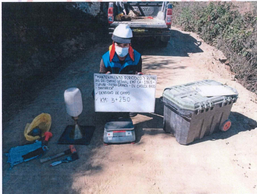
FIGURA N° 14. Ensayo de Densidad de Suelo en Campo. Progresiva 03 + 250 (Método del cono de arena).
