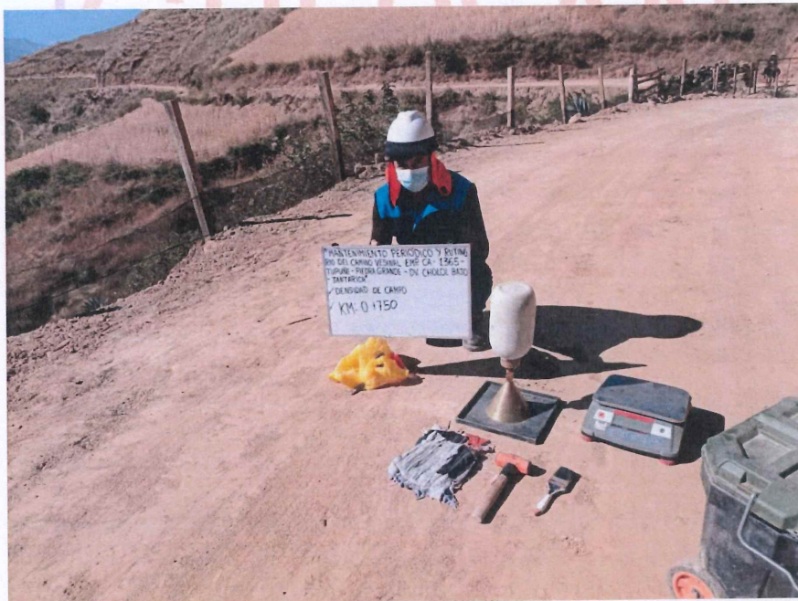
FIGURA N° 4. Ensayo de Densidad de Suelo en Campo. Progresiva 00 + 750 (Método del cono de arena).
