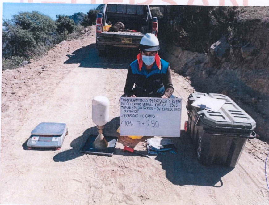
FIGURA N° 30. Ensayo de Densidad de Suelo en Campo. Progresiva 07 + 250 (Método del cono de arena).
