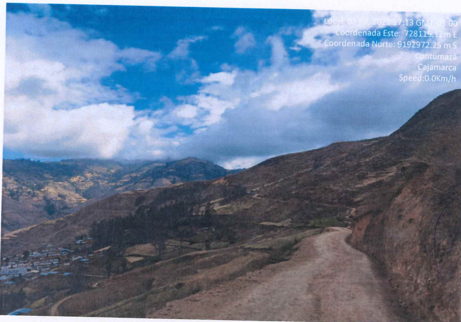
Fotografía 2. Resultado de los trabajos de transporte de material excedente D> 1 Km
