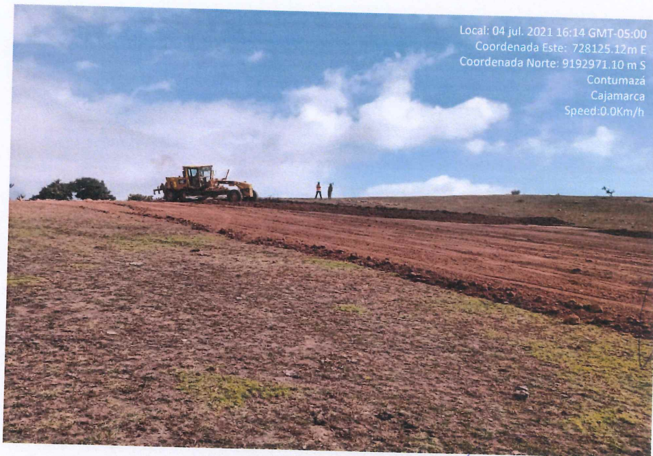
Fotografía 4. Resultado de los trabajos de recuperación de áreas ocupadas.
