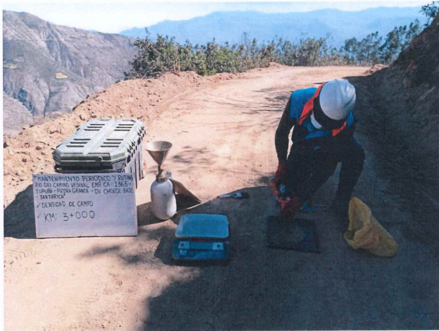
FIGURA N° 13. Ensayo de Densidad de Suelo en Campo. Progresiva 03 + 000 (Método del cono de arena).
