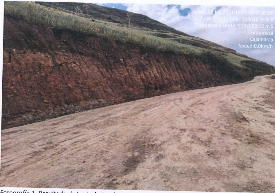
Fotografía 1. Resultado de los trabajos de transporte de material excedente D> 1 Km
