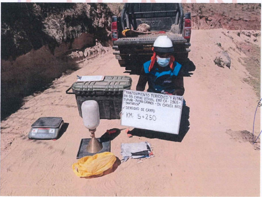
FIGURA N° 22. Ensayo de Densidad de Suelo en Campo. Progresiva 05 +250 (Método del cono de arena).
